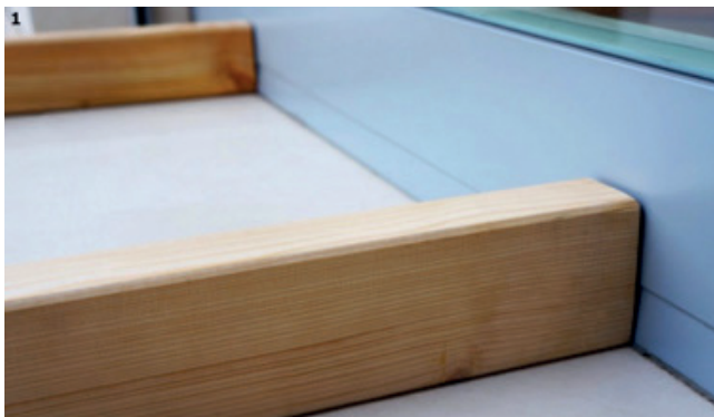
1. Unterkonstruktion waagrecht ausrichten
