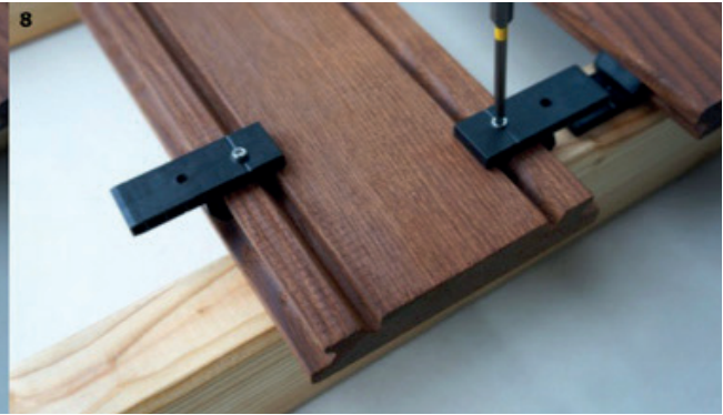
8. Verbinder mit der Anschlussdielen verschrauben
