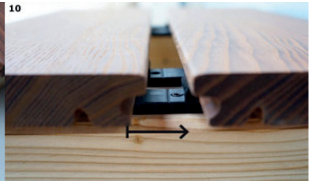
10. und unter die bereits montierte Dielen schieben
