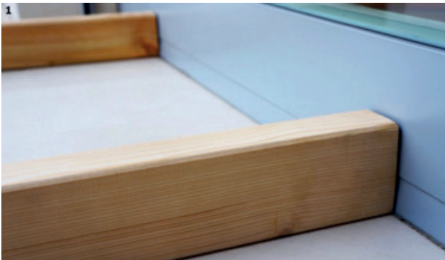
1. Unterkonstruktion waagrecht ausrichten
