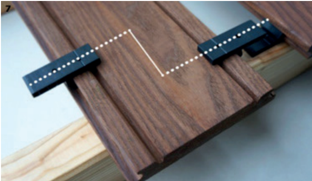
7. Anschlussdielen mit der Oberflächenseite auf die Unterkonstruktion legen und die Verbinder wie in der Abbildung ausrichten
