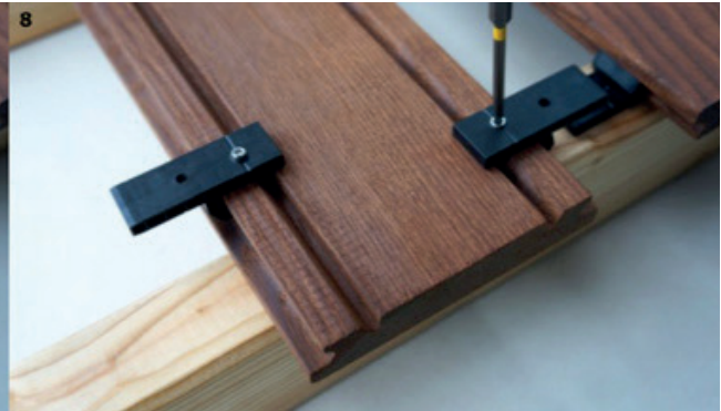
8. Verbinder mit der Anschlussdielen verschrauben
