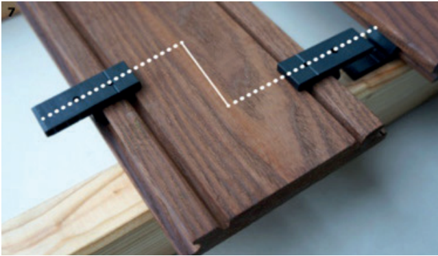
7. Anschlussdielen mit der Oberflächenseite auf die Unterkonstruktion legen und die Verbinder wie in der Abbildung ausrichten
